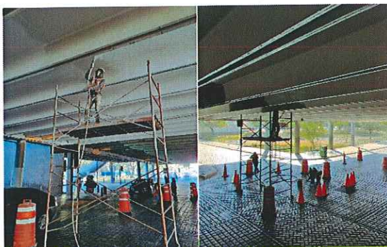
Reparación estructural losa jardín en Macroplaza
