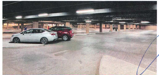
Rehabilitación de Estacionamiento Macroplaza
