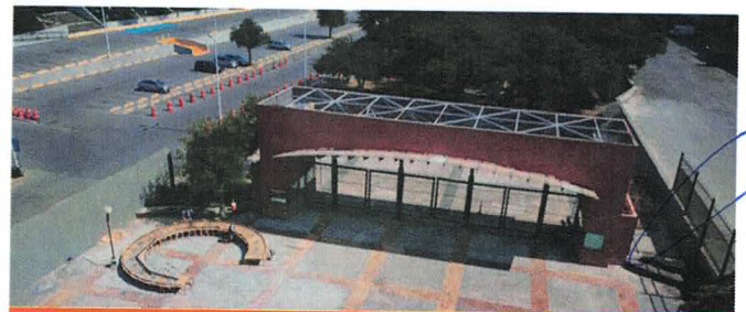
Rehabilitación de accesos
