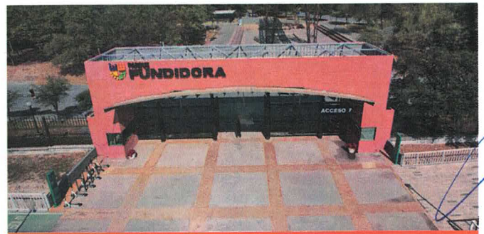
Rehabilitación de accesos
