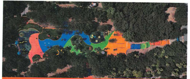
Construcción de Zona Infantil
